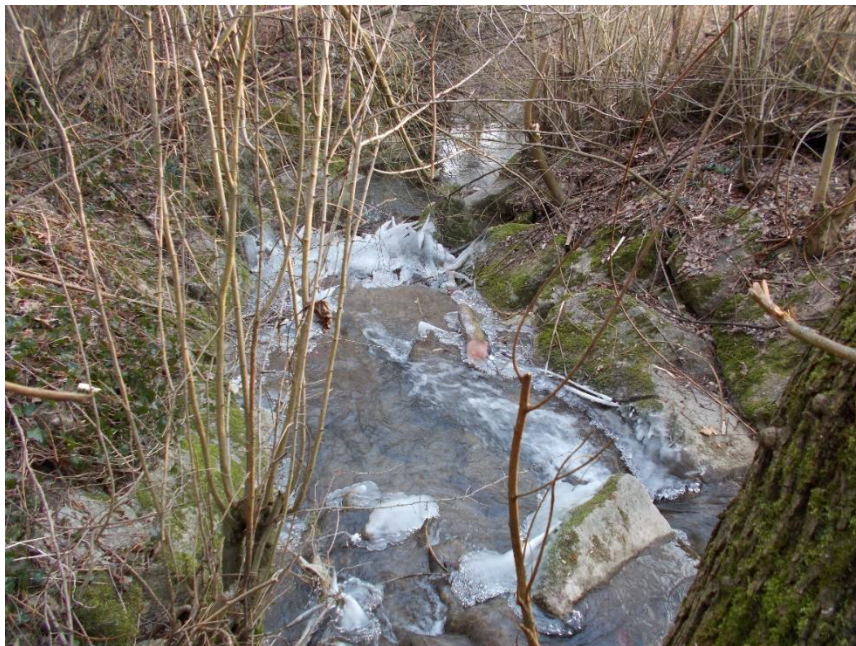
Abbildung 20: Einleitstelle des gering belasteten Strassenwassers in den Küntenerbach. Dieser kleine Mittellandbach weist hart verbauete Ufer und ein verhältnismässig grobes Sohlensubstrat auf.
